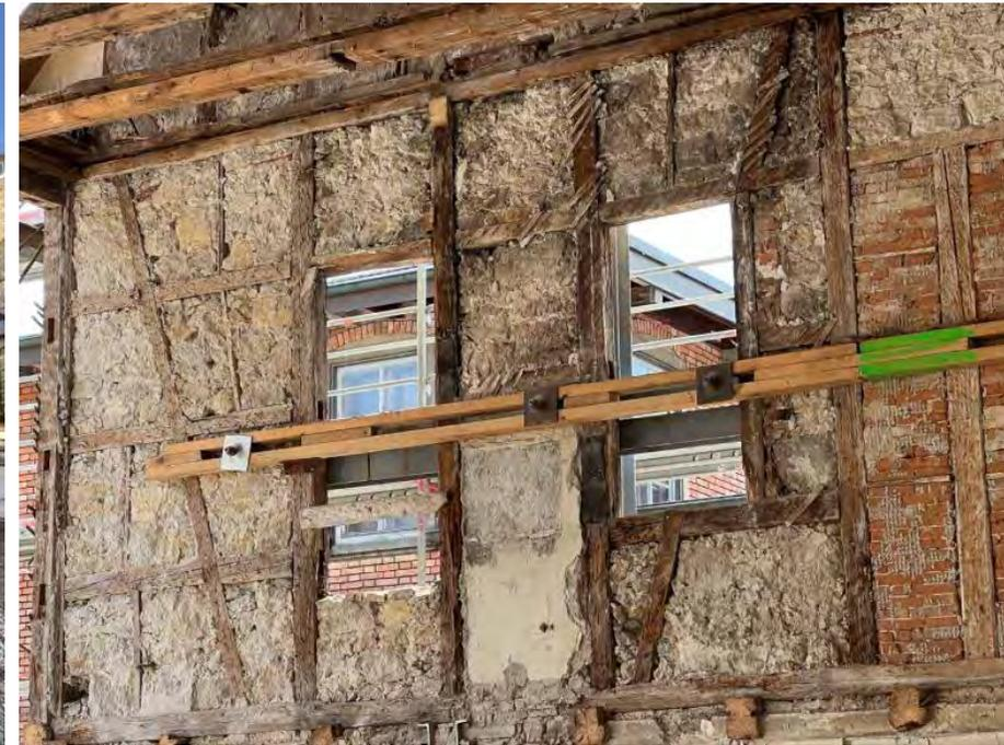
Notwendige Stabilisierungsmassnahmen der fragilen Riegelkonstruktion
