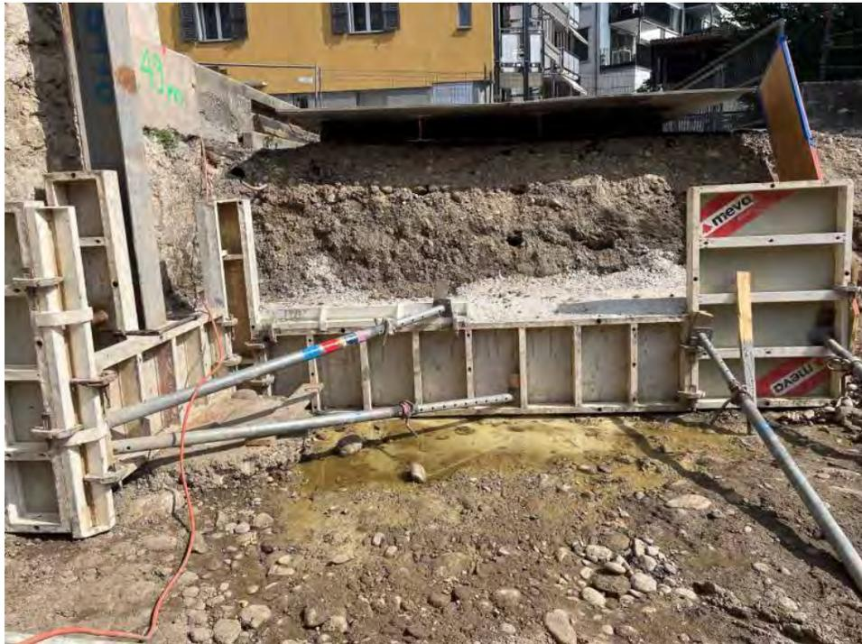
Mühletuch war undicht und musste abgedichtet und verstärkt werden
